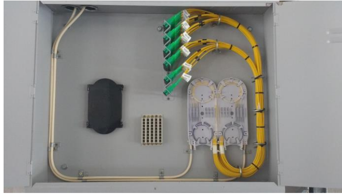
Fig 18. 1. Armario con varios cassettes.
